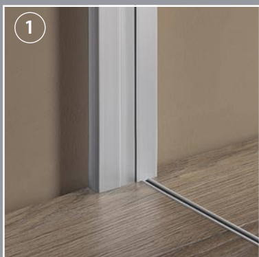
1 Zabezpieczenie ściany profilem przed uszkodzeniem drzwiami. Protection of the wall with the profile against door damage.
